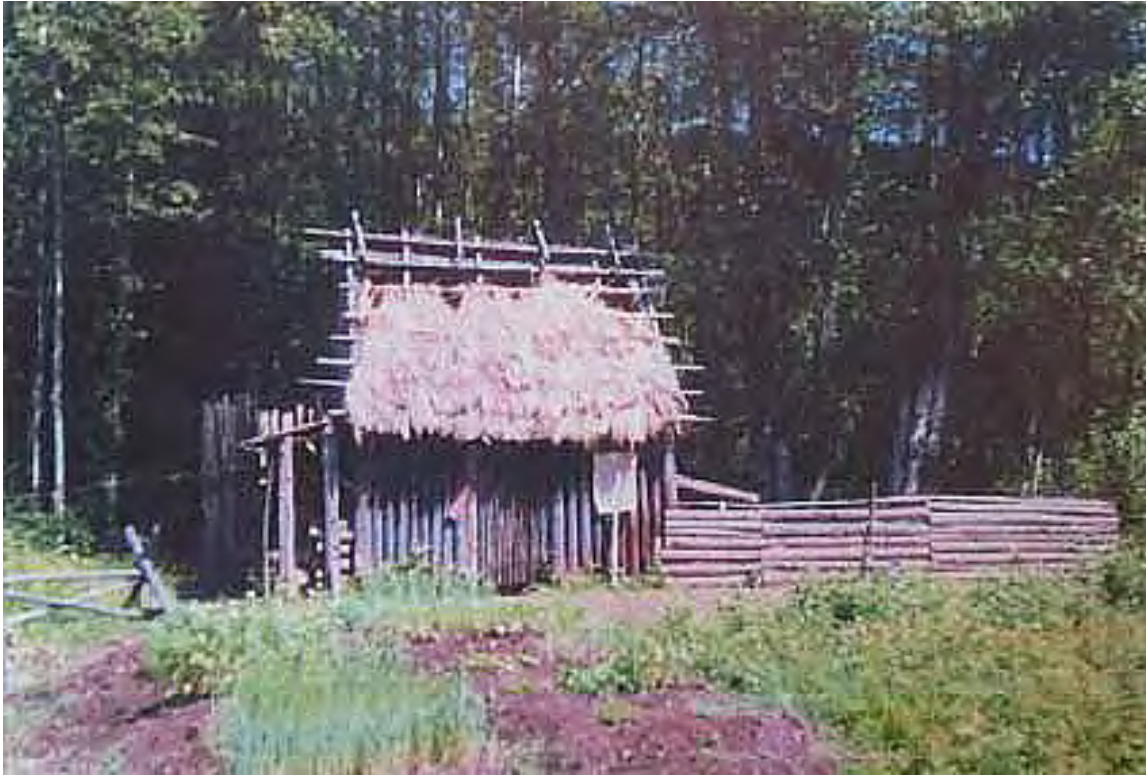
La première maison du colon, sitôt en possession de sa terre, était généralement construite de pieux debout et couverte de chaume.
